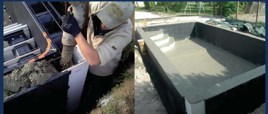
4. Gießen des Betons
